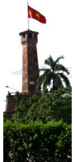
Torre de la bandera.
